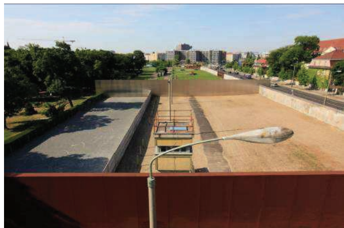
Abb. 7: Blick über das Denkmal Richtung Nordbahnhof
