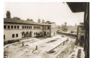
Versetzung der Verkündigungskirche der »Nonnen-Einsiedelei«, Bukarest 1982 Courtesy Dr. Ing. Eugeniu Iordăchescu
